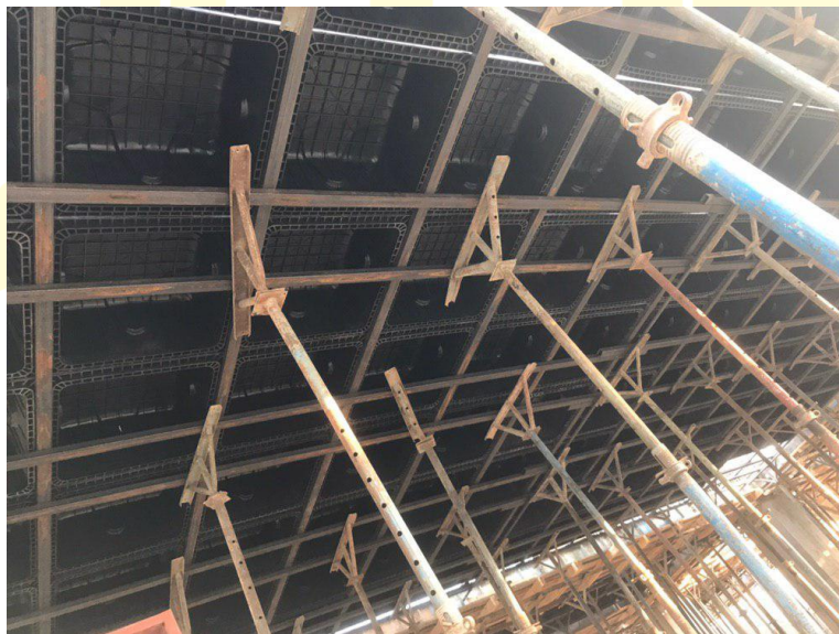
روش اجرائى مدولار سقف وافل (عدم نياز به كفراژ سطح)
